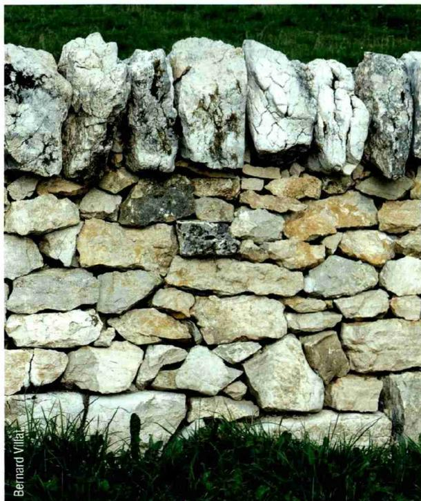
Base: grosses pierres plantées dans le sol; puis pierres de taille moyenne avec les cailloux de remplissage, les plus petites placées en haut; à intervalles réguliers, longues pierres traversant le mur de part en part pour assurer la solidité de l'ensemble; en haut, magnifiques pierres de couverture préservant la construction des aléas météorologiques.
